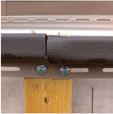
Неверное соединение J-профилей. Саморезы вкручены в края перфорации.
