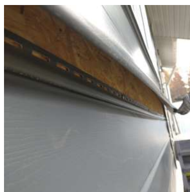
Монтаж без обрешетки. Саморезы вкручены в край перфорации.
